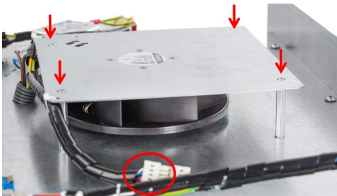
Figura 38: smontaggio del ventilatore
